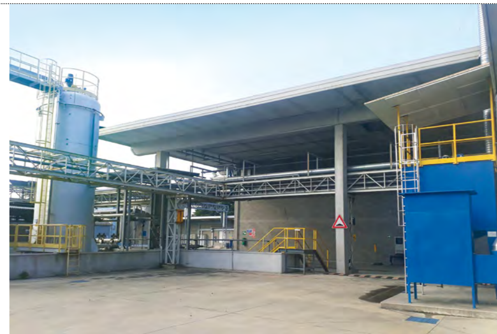
Filtro a carboni attivi e colonna di condensazione per l'abbattimento delle emissioni gassose e antincendio dedicato per ogni sezione dell'impianto
