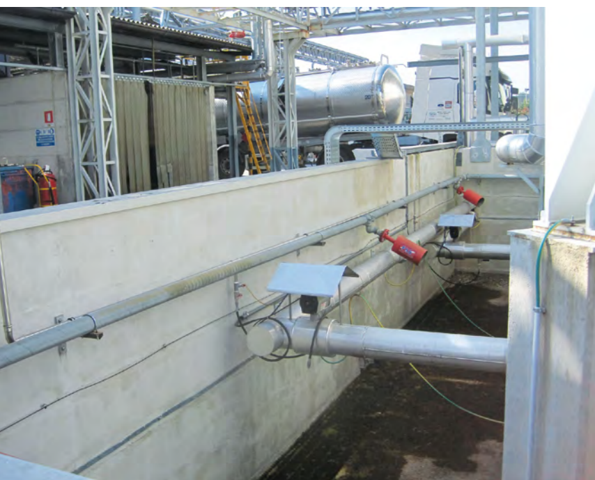
Bacino di contenimento dei serbatoi inertizzati in azoto. Cavi termosensibili e cannoni a schiuma a media espansione ne circondano il perimetro
